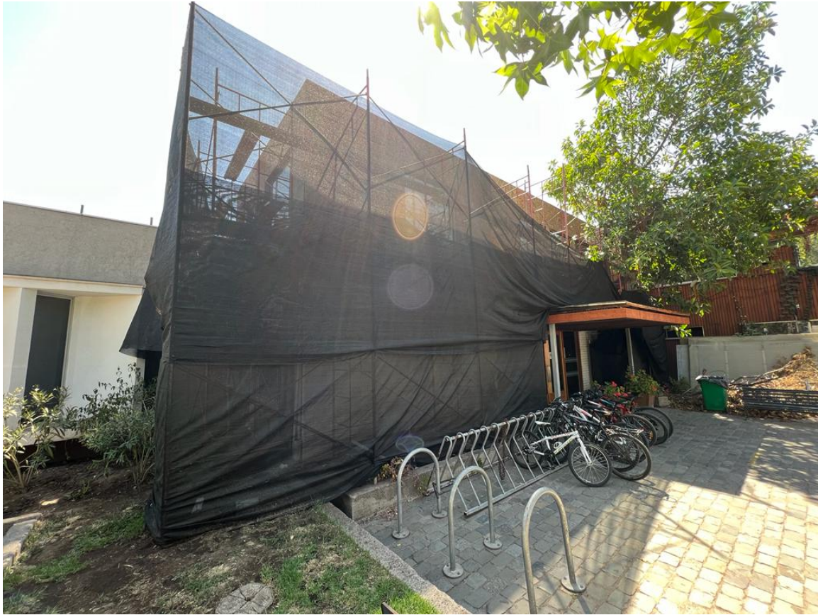
Reparaciones fachada finanzas
