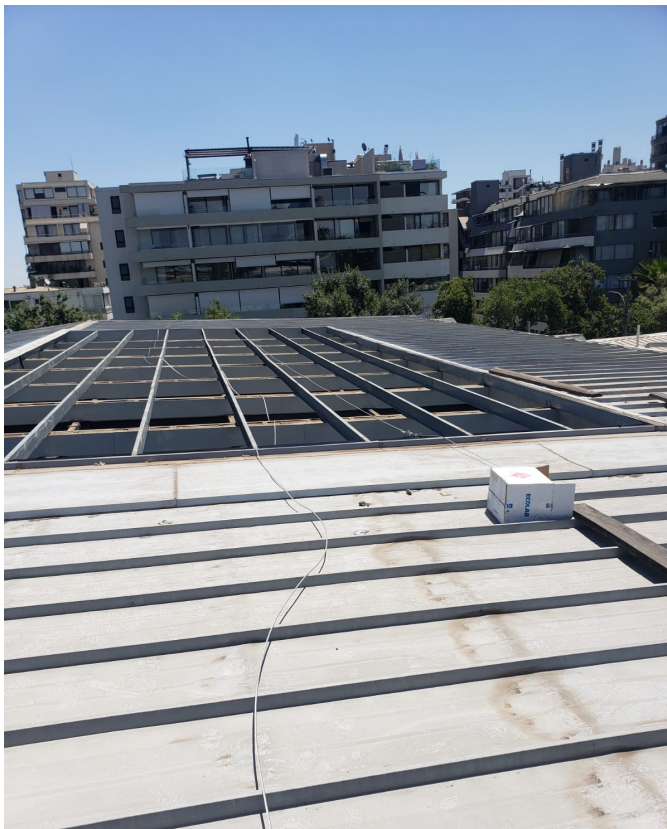
Reparación techumbre fitness
